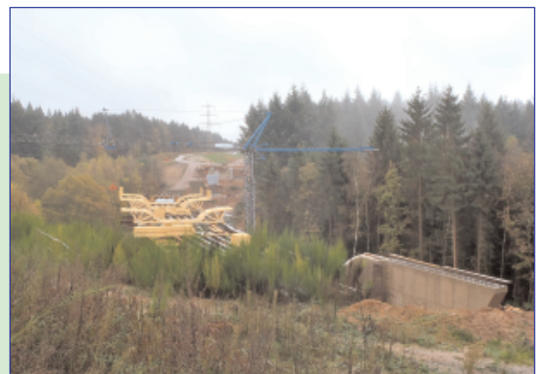
Eine weitere Umgehungsstraße (das Foto zeigt die im Bau befindliche Umgehung Bessringen) brauchen wir in diesem Wald nicht.
